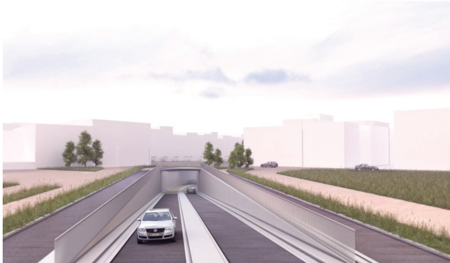
Figuur 4: Tunnelmond kant Kortrijk Weide/ B. Lambrechtlaan
