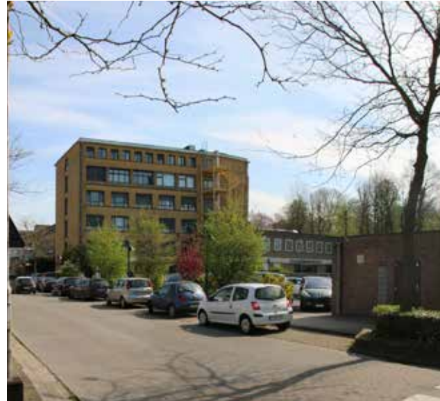
VOORMALIGE WESTELIJKE ZIJGEVEL VAN GEBOUWEN AZ GROENINGE LANGS LOOFSTRAAT
