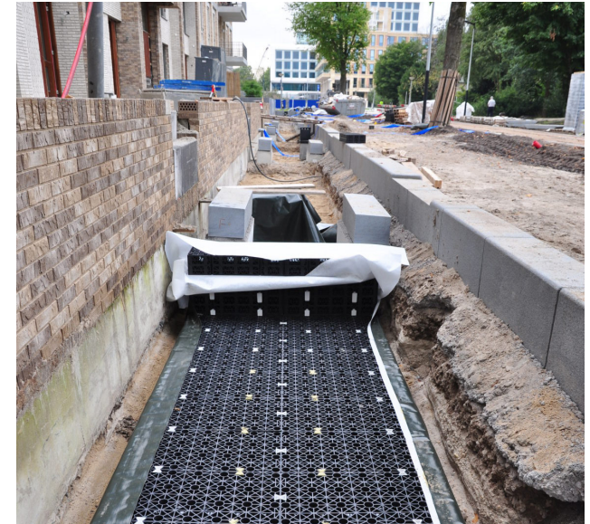
infiltratie: TSG - De Groenen Beek - Amsterdam
