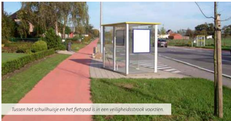
Figuur 129: Uitbuigende fietspad ter hoogte van de halte (Bron: Fietspaden in Vlaanderen - Goede praktijkvoorbeelden)
