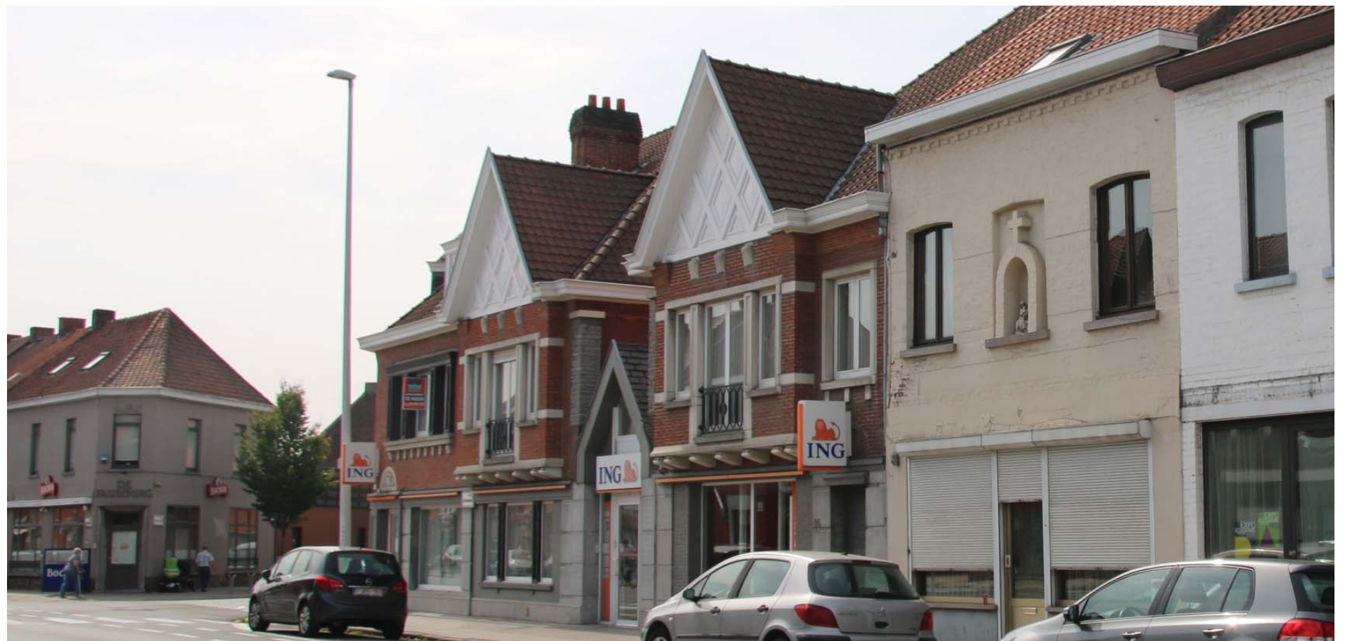
BANK LANGS DE BRUGSESTEENWEG
