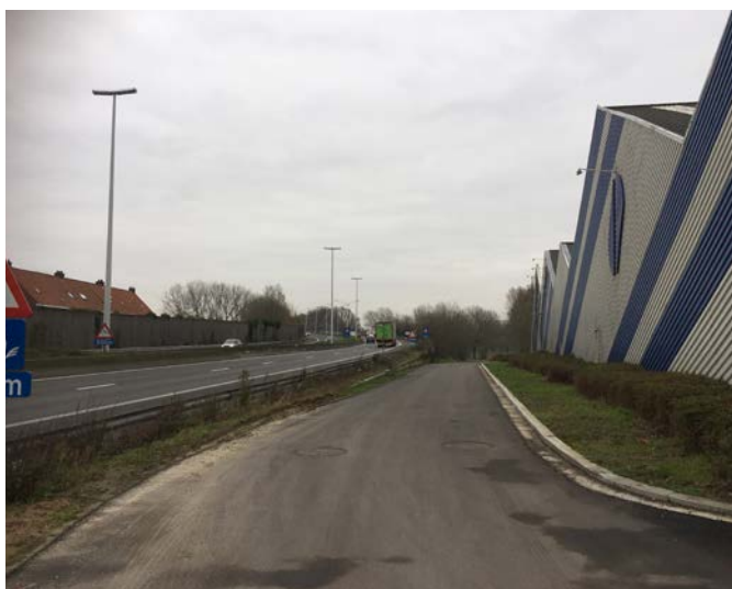
9. Zicht op de weg tussen R8 en loods van der Wiele
