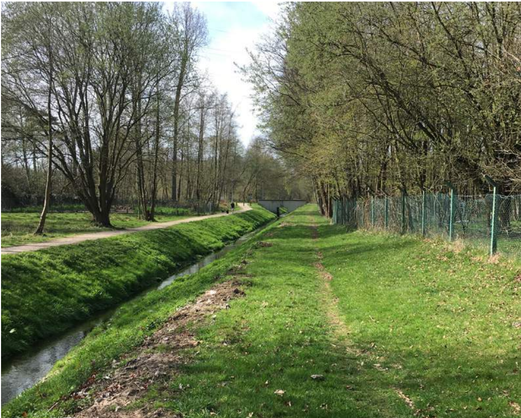
De Stiemer vallei, Genk: De gekanaliseerde beek zal begeleidt worden door een parallelle beek, welke de natuurlijke valledynamiek vergroot en ruimte biedt voor water tussen de stedelijke kernen van Genk.
