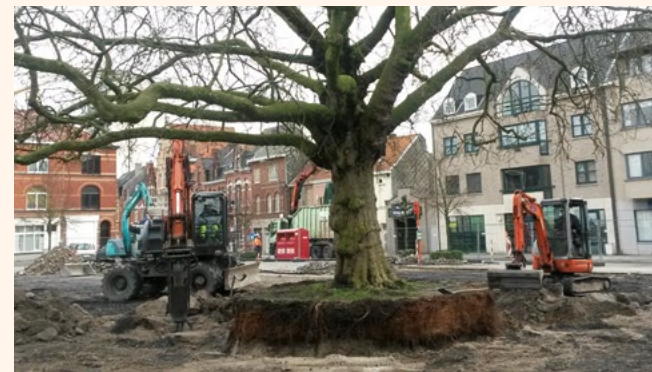
De grote plataan wordt bevrijd uit de betonnen bak.
