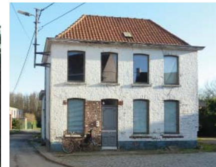
Recente verbouwing vrijstaande burgerwoning bron: leiedal, februari 2014
