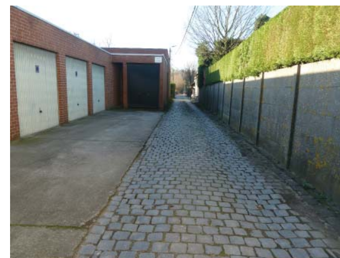
8 – PARALLEL AAN DIT STRAATJE LOOPT EEN TWEEDE WESTLIJKE ZIJSTRAAT IN WALLE MET EEN STERK PRIVAAT KARAKTER. DEZE IS GEKENMERKT DOOR EEN REEKS GARAGEPOORTEN, EEN GESLOTEN TUINOMHEINING EN ENKELE VRIJSTAANDE WONINGEN OP HET EINDE VAN DE STRAAT.
