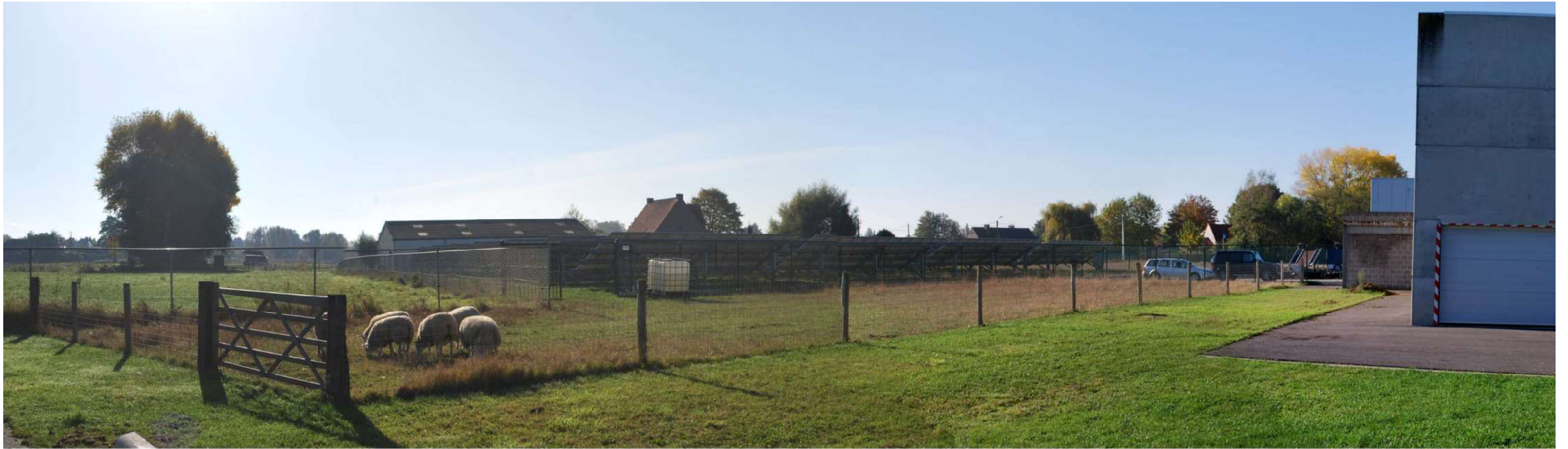
ZONNEPANELEN OP HET PERCEEL (EIGENDOM ESCA FOOD) NAAST DE BRANDWEER
