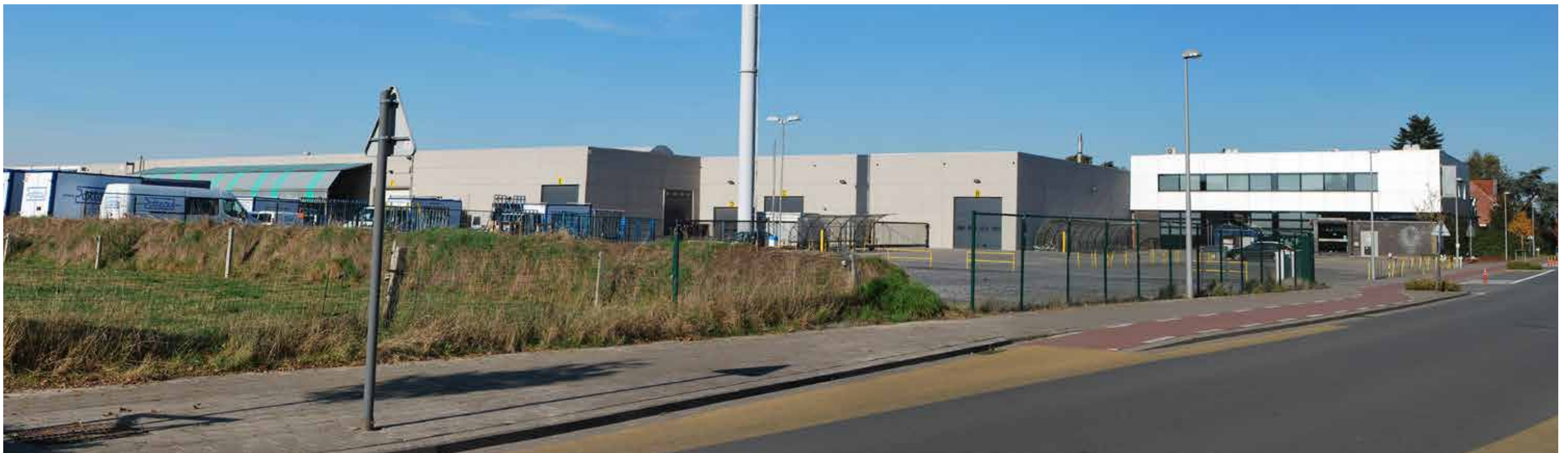
ZICHT OP POTTEAU LANGS DE ZUIDSTRAAT
