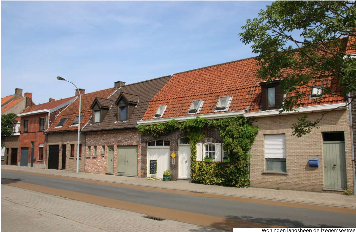
Woningen langs de Izegemsestraat
