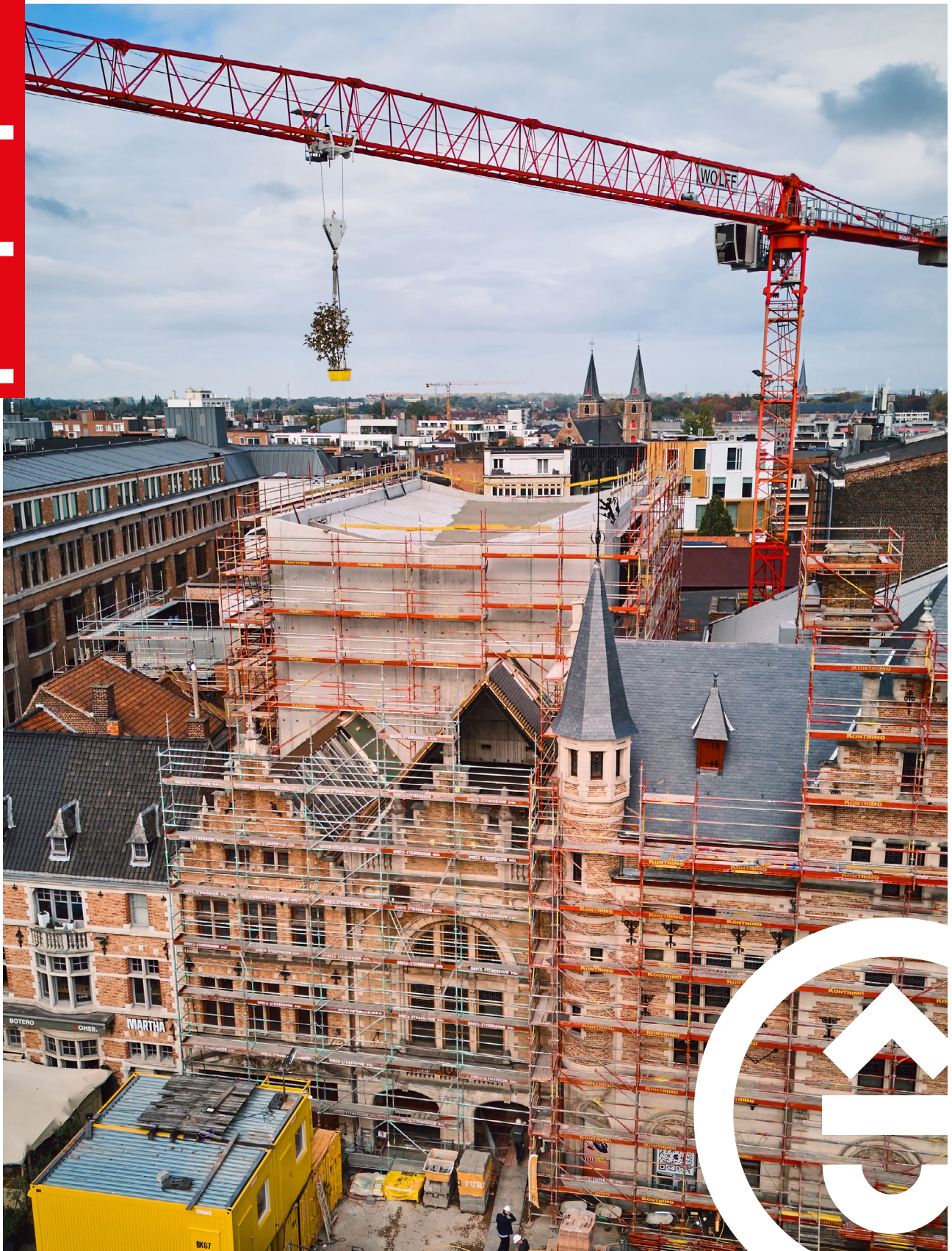
De meiboomviering markeert het einde van de ruwbouwwerken aan de schouwburg.
