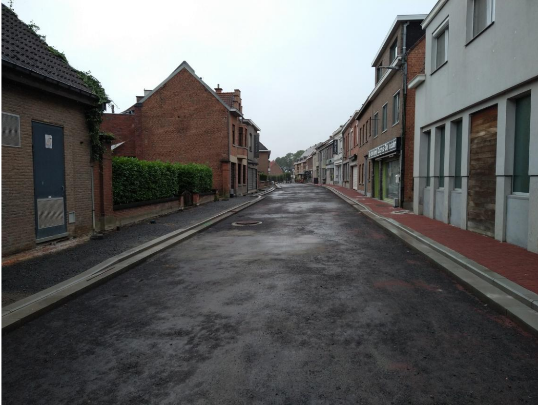
Aanleg onderlaag asfalt
