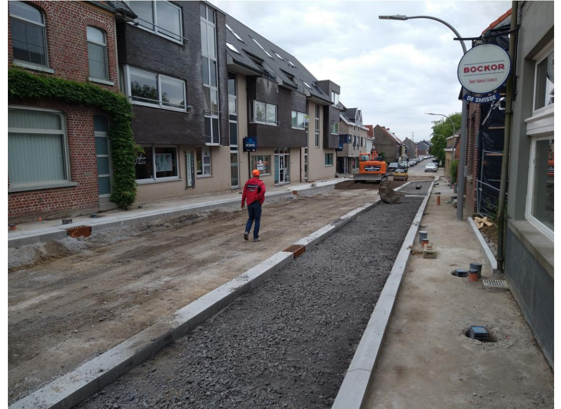
Plaatsen fundering parkeerstroken en voetpaden
