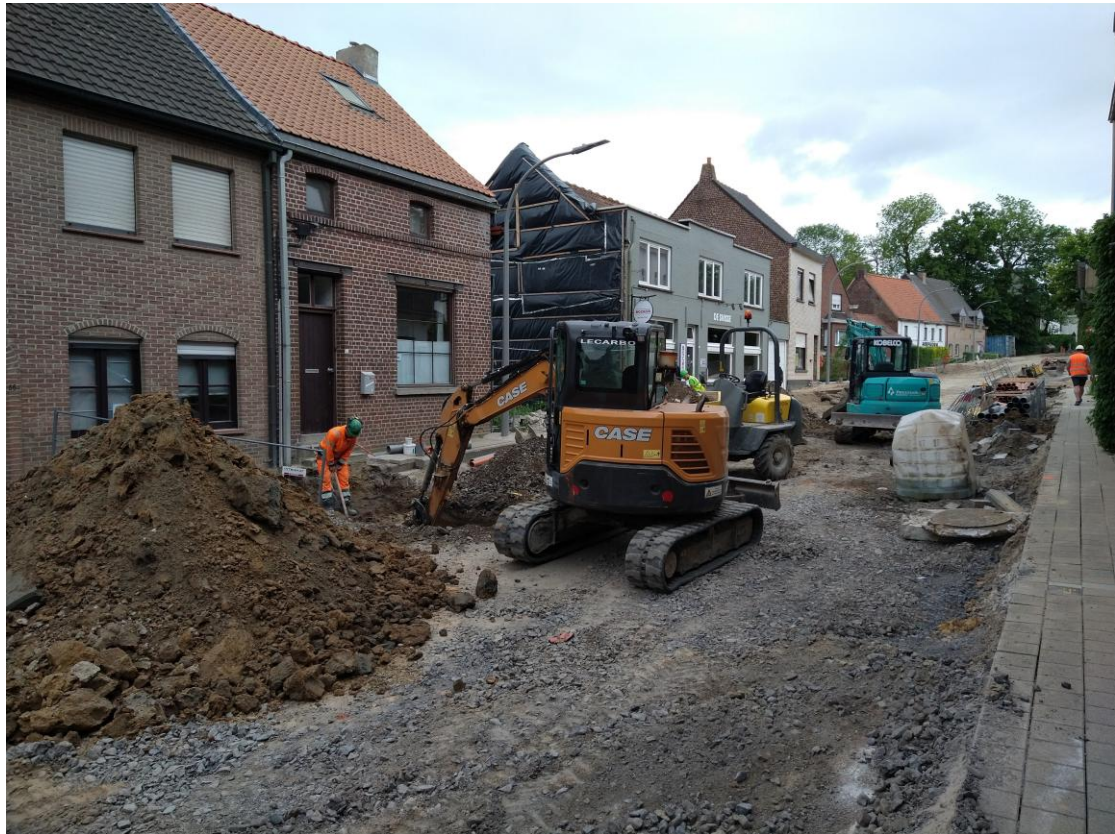
Aansluiting riolering van woning op nieuwe riolering in de straat
