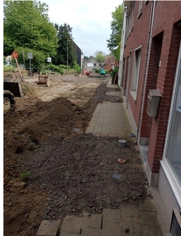
Tijdelijk herstel voetpad na aansluiting woning op riolering
