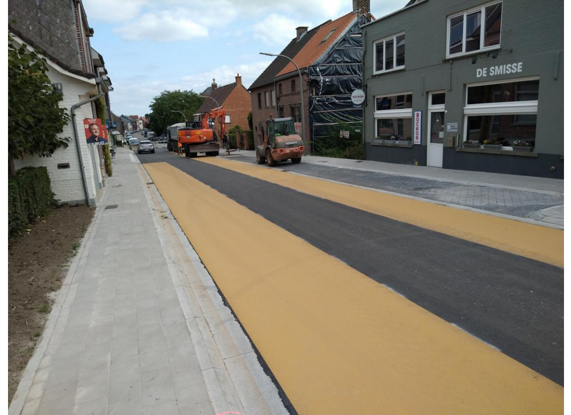
Aanleg toplaag asfalt en verfmarkeringen
