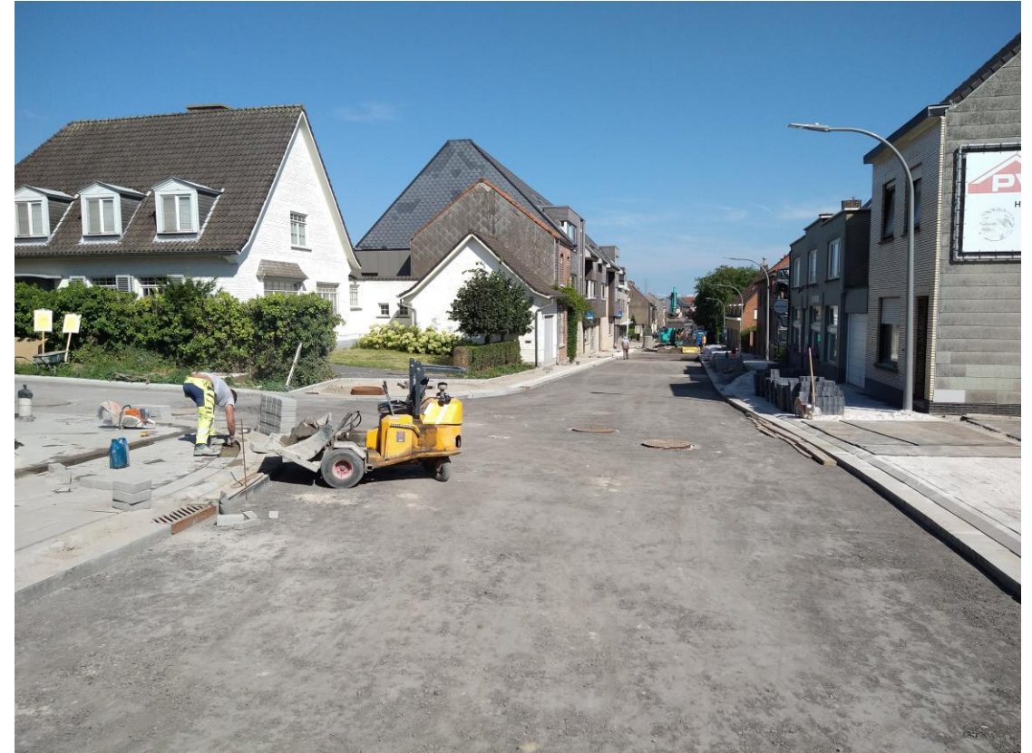
Aanleg fundering rijweg
