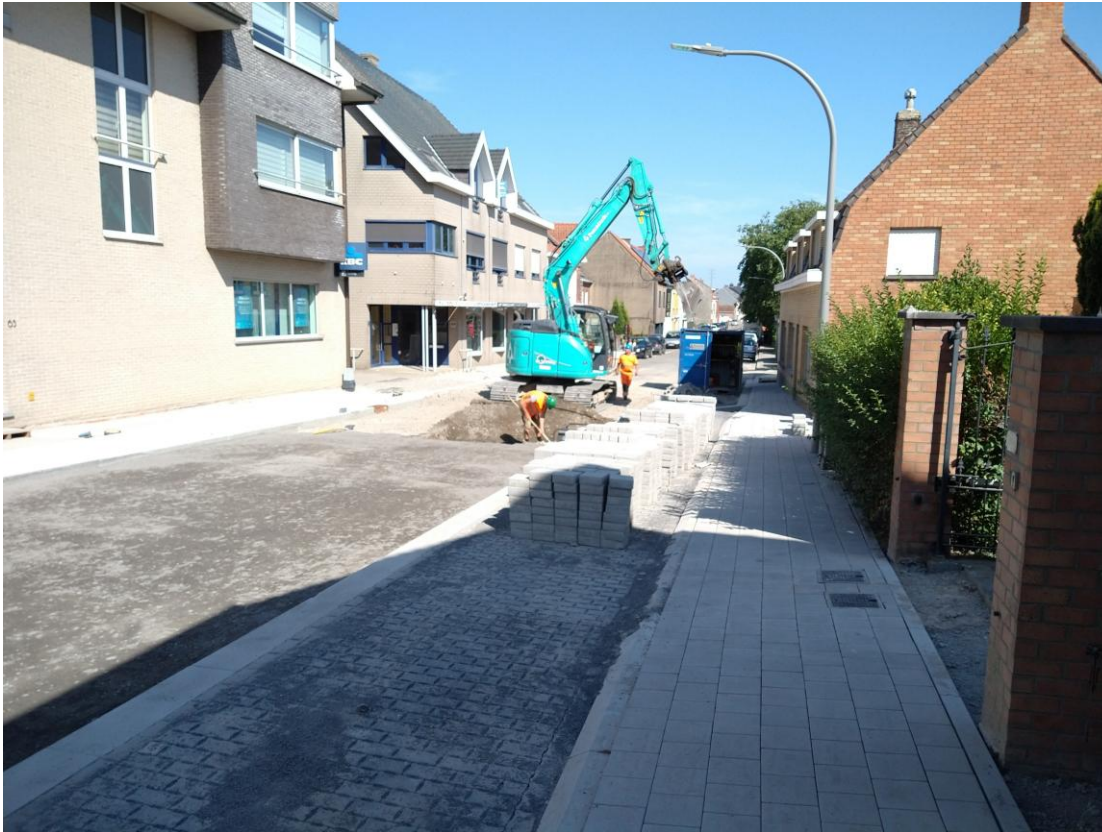
Aanleg voetpaden en parkeerstroken
